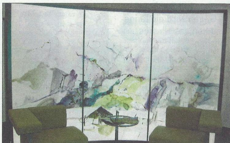
Mit Hilfe speziell angefertigter Schablonen wurden die Plexiglastafeln bei 75 Grad und Druckeinwirkung zwölf Stunden in Form gebogen. Foto: Rieder
